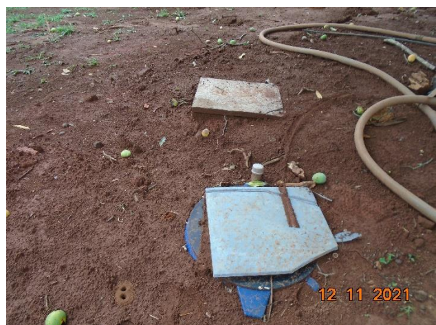
Foto 2: Biodigestor para tratamento de efluentes
