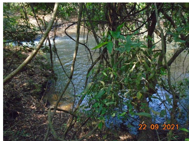
Figura 04: Instalação de estruturas para captação hídrica.
