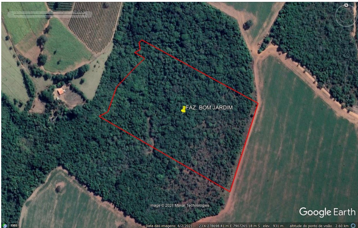
Figura 01: Imagem aérea do empreendimento. Fonte: Google Earth Pro
