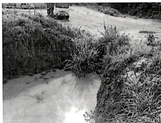
Imagem 43 e 44: Sumps de contenção de sedimentos da pilha estéril. Fonte: PCA (2020).
