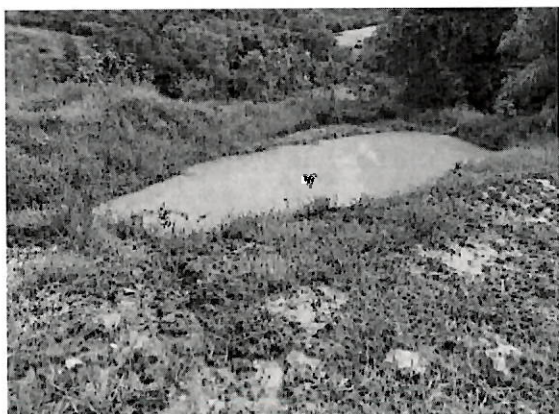
Imagem 43 e 44: Sumps de contenção de sedimentos da pilha estéril. Fonte: PCA (2020).
