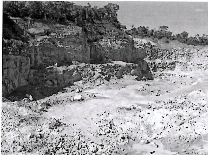
Imagem 26: Vista da cava com o maciço de rocha gnaisse de coloração acinzentada. Fonte: EIA (2020).
