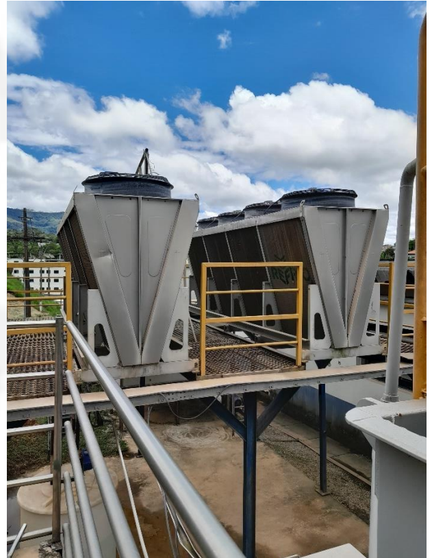
Figura 04: Estação de Tratamento de Água (ETA)
