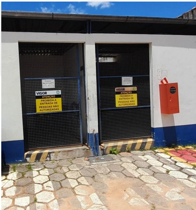
Figura 09: Depósito Temporário de Resíduos (DTR) – Resíduos não perigosos.
