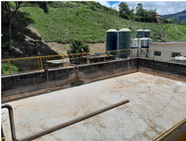
Figura 01: Estação de Tratamento de Efluentes (ETE) - Tanque de equalização.
