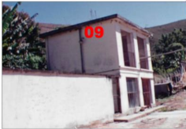
Imagem 09: Imagem da década de 90, pertencente ao acervo da empresa e apresentada juntos aos autos, demonstrando o prédio da sala de supervisor.
