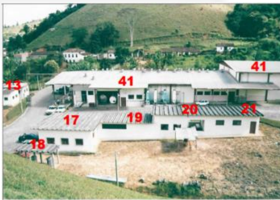
Imagem 11: Imagem da década de 90, pertencente ao acervo da empresa e apresentada juntos aos autos, demonstrando a caldeira, sala Sif / Qual./ Lab de Microbiologia, estrutura antiga, depósito de químicos, sala de supervisores, sala de reunião / depósito de produto químico e prédio industrial.
