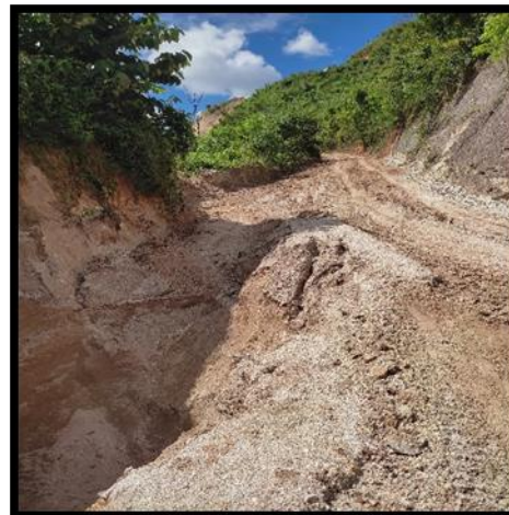
Figura 6 Via de acesso/sistema de drenagem
