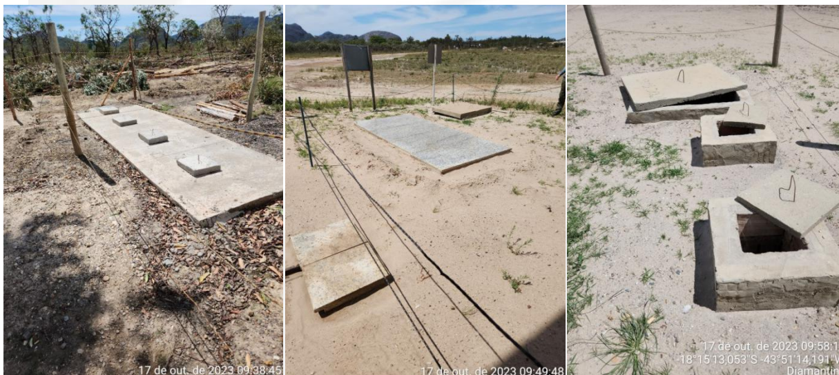
Fotos 4, 5 e 6 – Fossa séptica e Caixas SAO.
