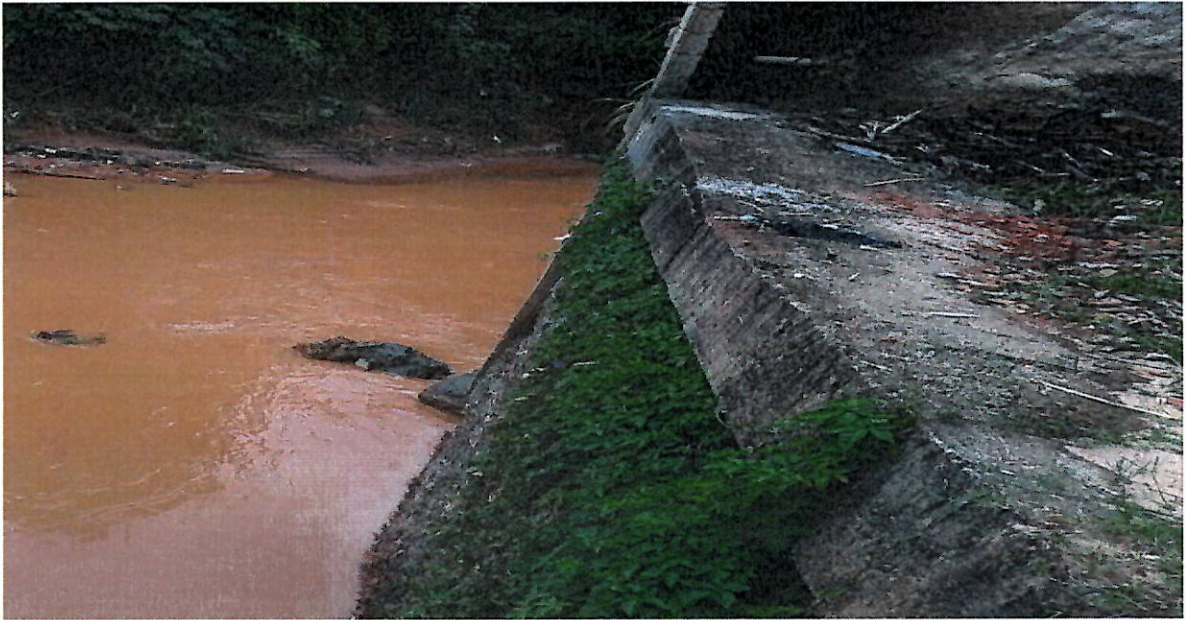
Legenda: foto 01 - local da construção do muro.
