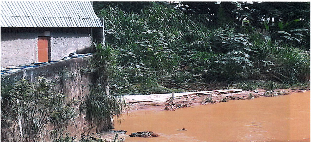
Legenda: foto 04 - local da construção do muro.
