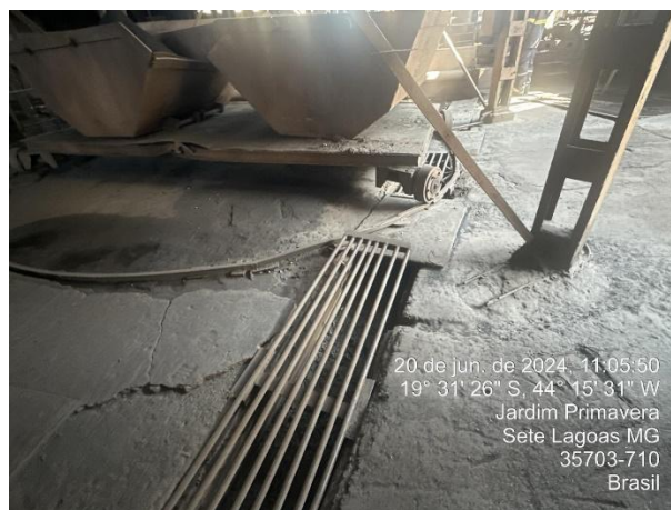
Foto 26: Canaleta de drenagem localizada dentro do galpão do alto-forno
