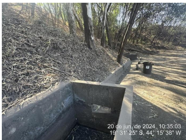
Foto 23: Caixa de passagem de efluente pluvial, que contempla sistema de drenagem próximo ao pátio de matéria prima da SDS
