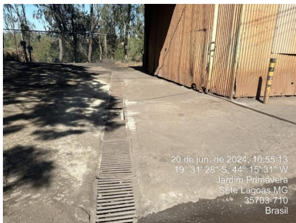
Foto 25: Canaleta de drenagem do complexo industrial, localizada próximo à área de alto-forno 01
