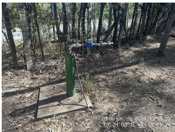
Foto 99: Poço tubular que não está em operação.
