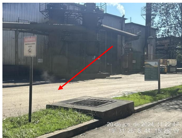
Foto 20: Caixa a qual pertence ao sistema da termelétrica, e funciona como um exaustor para saída de parte de vapor do sistema
