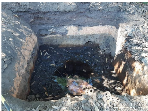
Foto 85: Detalhe da escavação para implantação da caixa de recepção do sistema de drenagem.
