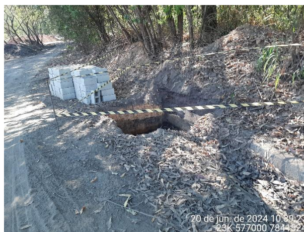
Foto 84: Caixa de recepção do sistema de canaletas que acompanha o acesso a pilha de escória.
