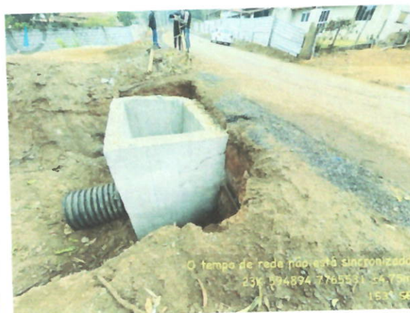
Figura 15: caixa de buco construída em APP. Nas imediações do Ribeirão Aranha, trecho Aranha a Suzana, sob as coordenadas 23k 594894 7765531. Fonte: arquivo SEMA.
