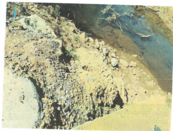
Figura 9: Curso hídrico visto da ponte que passou por alargamento no eixo central. Ponte Marques-Piedade, sob as coordenadas 23k 599315 7767861.
