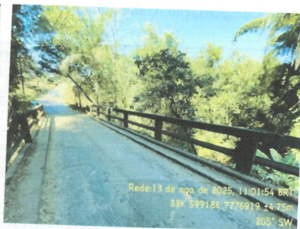
Figura 17: Ponte a ser melhorada no trecho Aranha a Suzana, conforme mencionado no projeto, sob as coordenadas 23k 599186 7776919. Fonte: arquivo SEMA.
