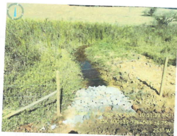
Figura 16: Dreno construído sob passagem de travessia, trecho Aranha a Suzana, sob as coordenadas 23k 600139 7764063. Fonte: arquivo SEMA.
