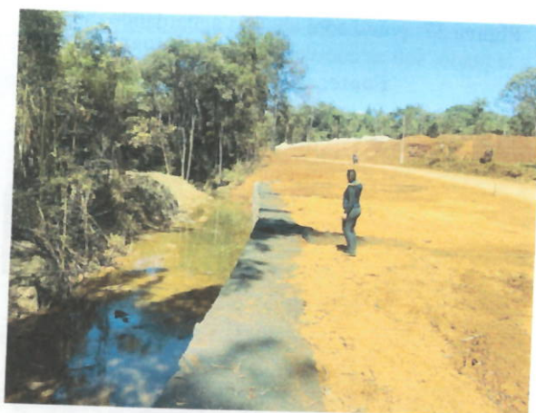
Figura 34: Vista de gabião construído em APP, estrada Piedade Paraopeba-Aranha, sob as coordenadas 23k 602729 7766842. Fonte: arquivo SEMA.
