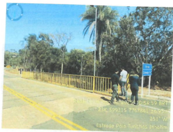
Figura 33: Ponte alargada em Marques-Piedade, sob as coordenadas 23k 599315 7767861. Fonte: arquivo SEMA.
