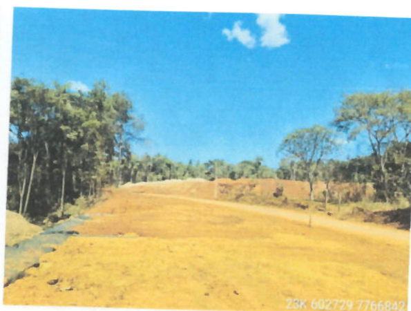
Figura 11: Terraplanagem realizada sobre gabião no eixo central, estrada Piedade Paraopeba-Aranha sob as coordenadas 23k 602729 7766842.
