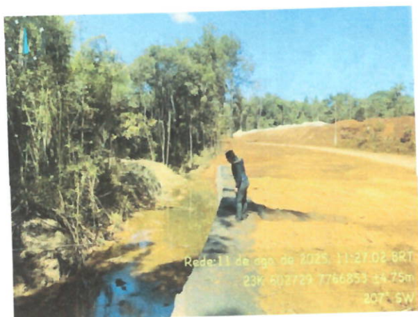
Figura 12: Vista para o gabião construído em APP, estrada Piedade Paraopeba-Aranha sob as coordenadas 23k 602729 7766853. Fonte: arquivo SEMA.
