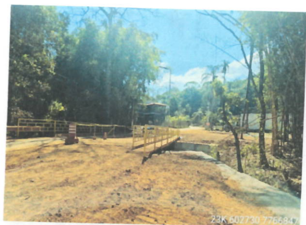
Figura 10: Ponte que passou por alargamento no eixo central, estrada Piedade Paraopeba-Aranha sob as coordenadas 23k 602730 7766847.
