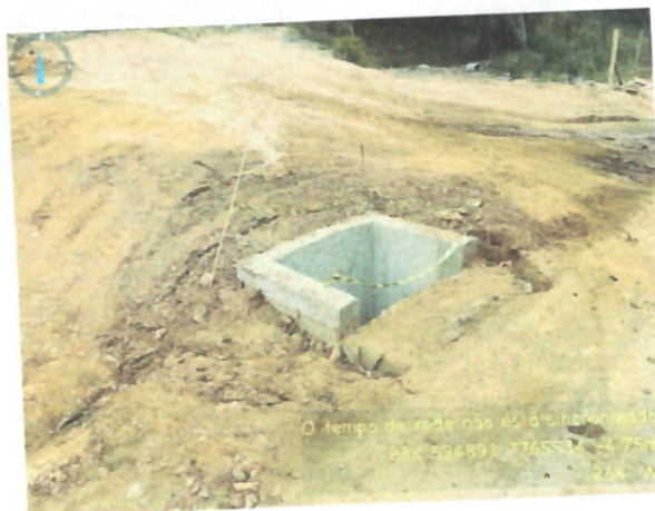
Figura 40: instalação de drenagem pluvial – boca de lobo, sob as coordenadas 23k 594891 7765534, trecho Aranha-Suzana.. Fonte: arquivo SEMA.
