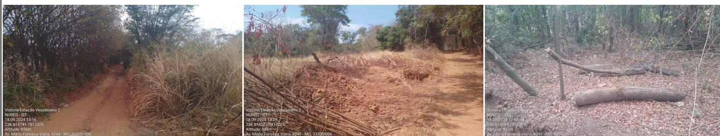
Figura 3 - Limpeza da margem da estrada de acesso e corte de árvores.
