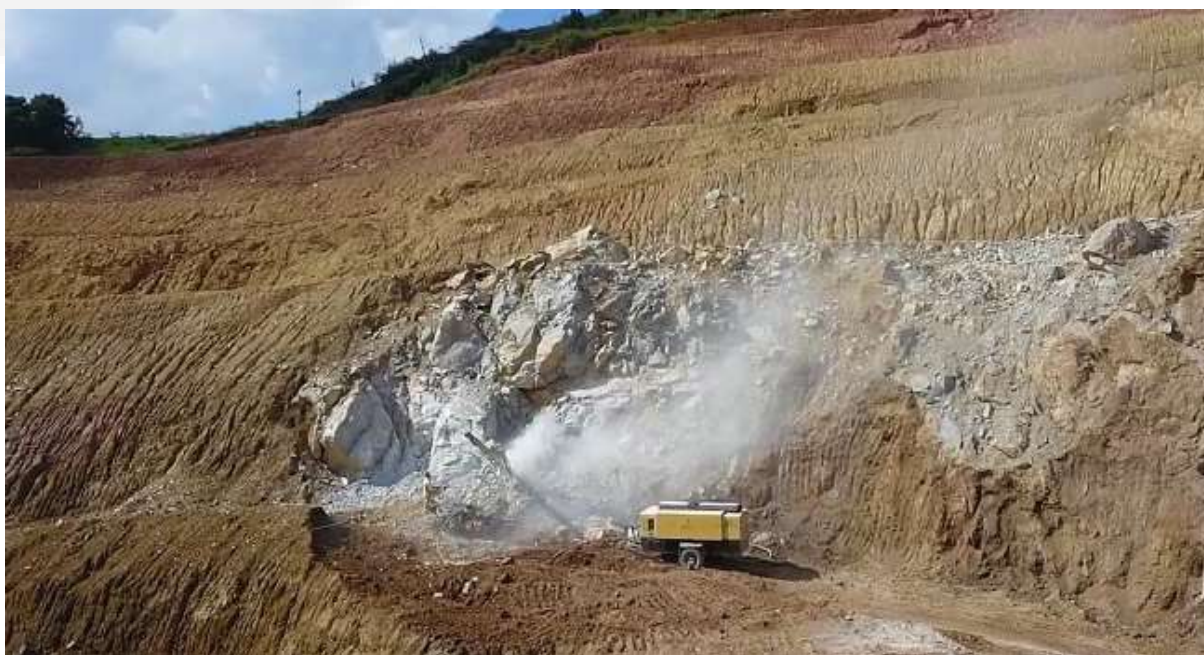
Figura 1 - Desmonte de rocha calcária no empreendimento
