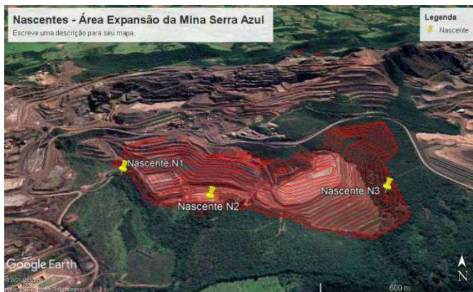
Figura 4.9: Nascentes presentes na ADA e AID do empreendimento. Fonte: Shapes do processo.
