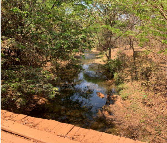
Foto 01. Ponte próxima ao eixo do barramento
