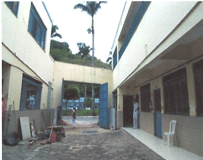
Parte interna da construção
