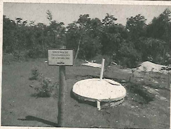
Foto 03: Área com sistema de tratamento chorume
