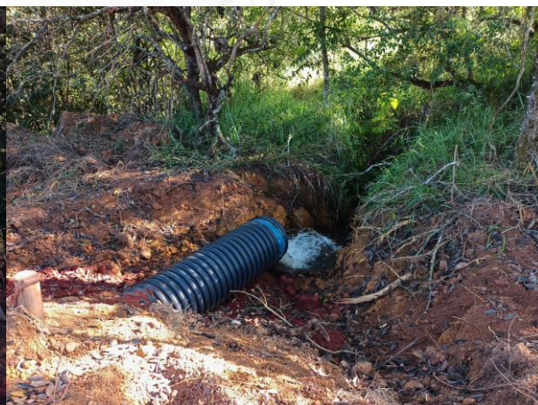
Fotos 3 e 4: Talude reformado e manilha instalada
