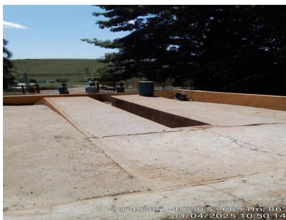
Foto 03. Lavador de veículos
