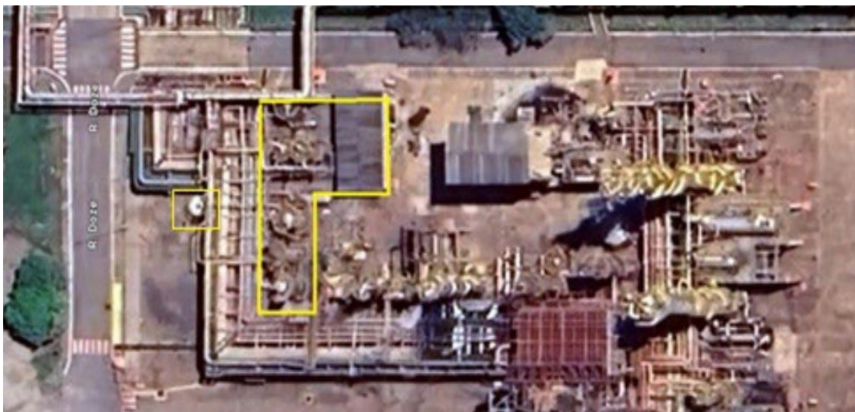
Figura 03 –Área do Tratamento Cáustico de Nafta Pesada e Nafta Leve e dos compressores do Sistema de Tratamento Cáustico Regenerativo de GLP TCRs – NL/NP na U-54 que serão Removidos para implantação da U-713.
