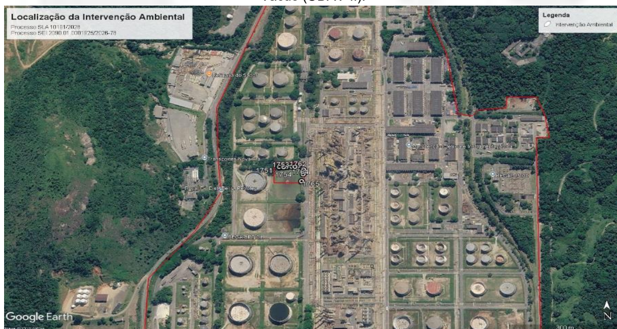
Figura 14: Localização da área objeto da intervenção ambiental e dos indivíduos arbóreos a serem suprimidos para a execução da revisão tecnológica das Unidades de Destilação Atmosférica e a Vácuo (UDAV-II).
