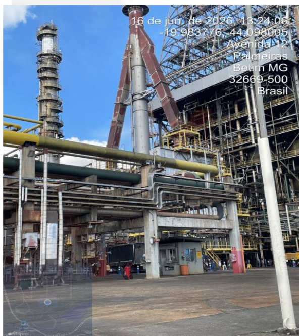
Foto 03. Unidade de coqueamento onde será implantada a nova unidade de tratamento de águas ácidas UTAA U-713.
