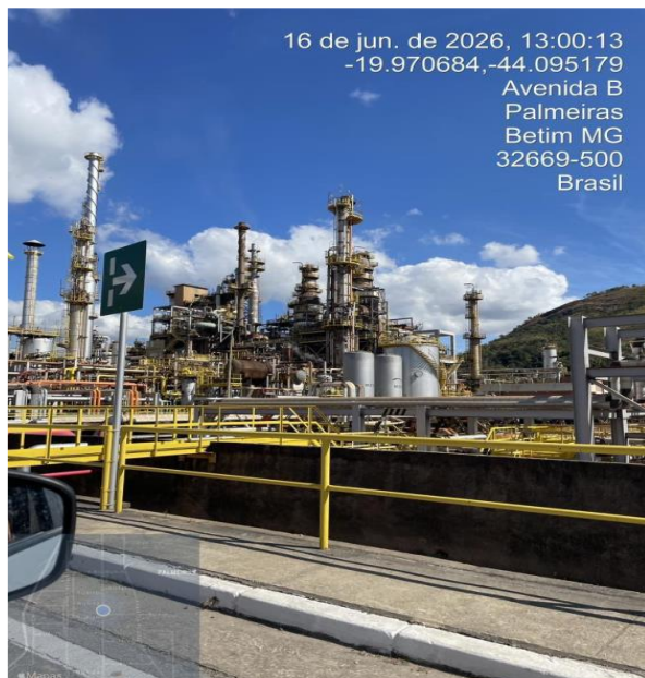
Foto 01. Área onde serão implementadas as melhorias previstas nas unidades de destilação (UDAV II U101/102)
