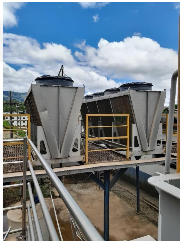
Figura 04: Estação de Tratamento de Água (ETA)
