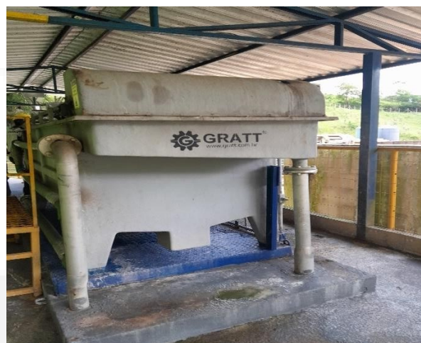
Figura 02: Estação de Tratamento de Efluentes (ETE) - Flotador etapa físico-química.
