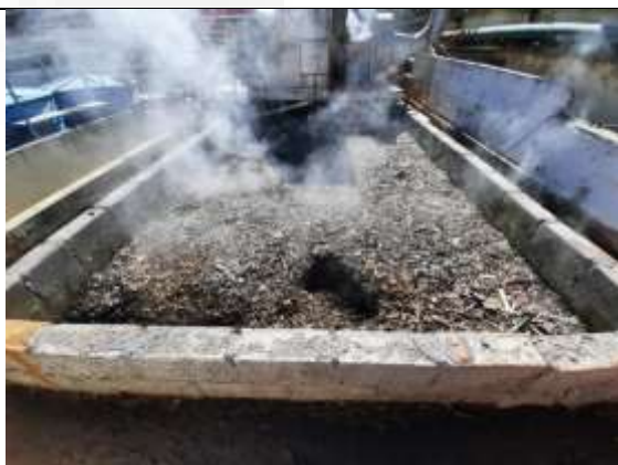
Figura 03: Filtro biológico de gases da fábrica de farinha e óleo.
