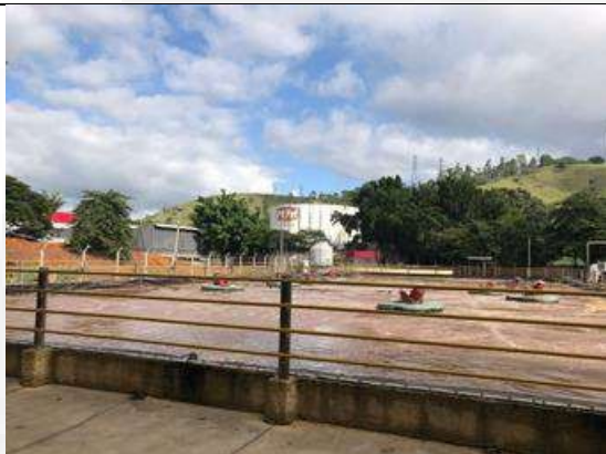
Figura 01: Vista da lagoa de aeração
