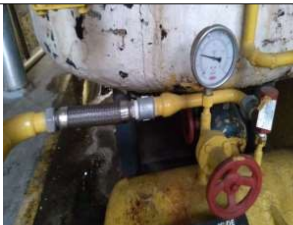
Figura 05: Tubulação do sistema de canalização das válvulas e tanques de armazenamento e dissipação do gás de amônia.
