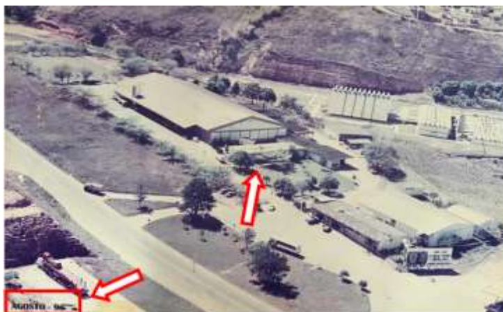
Fotografia do empreendimento datada de agosto de 1996.
