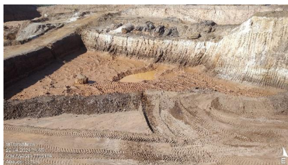
Foto 44: Bacia de contenção em área de mina. Porção centro norte da ADA.
