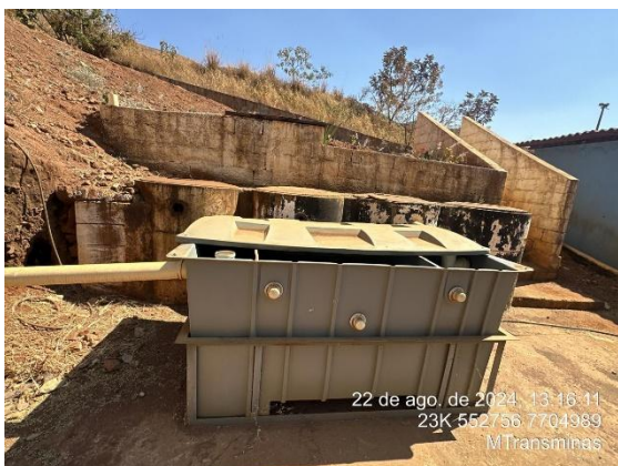
Foto 75: CSAO do empreendimento.
