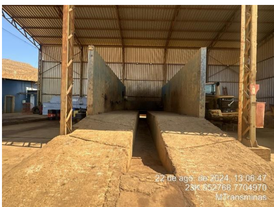
Foto 83: Vista da parte interna da repartição destinada ao lavador de veículos.
