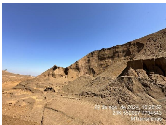
Foto 21: Pilha de rejeito com processo erosivo mais avançado que as demais.
