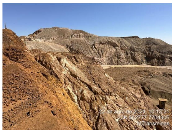
Foto 22: Vista geral de parte da pilha de rejeito.
