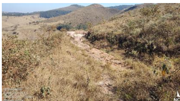
Foto 31: Acesso para bacia de contenção associada ao processo erosivo.
