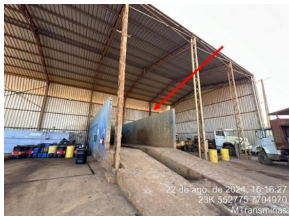
Foto 82: Seta indicando local do lavador de veículos.
