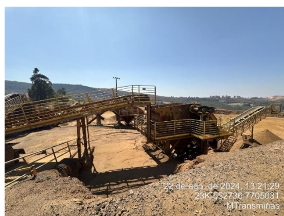
Foto 14: Vista de outra parte da planta de beneficiamento a seco.
