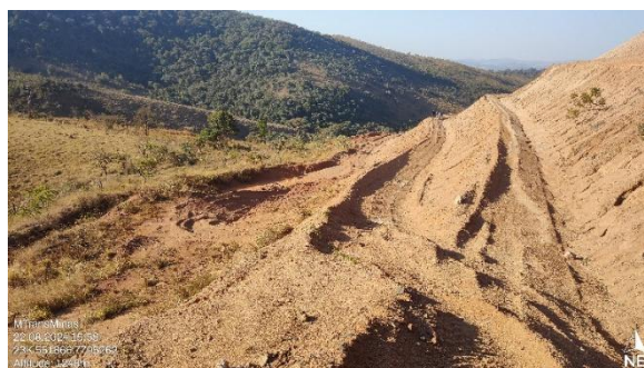
Foto 64: Talude em materiais inconsolidados da pilha de rejeito/estéril e à esquerda, bacia de contenção de sedimentos.
