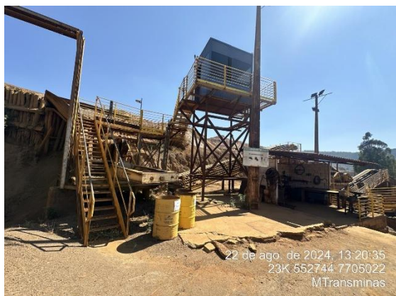
Foto 33: Vista do local da UTM a seco onde há acondicionamento de resíduos, dentre eles resíduos perigosos.
