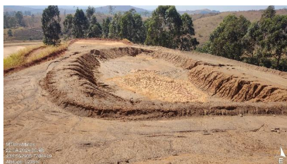
Foto 39: Bacia de contenção sobre pilha de rejeito/estéril.
