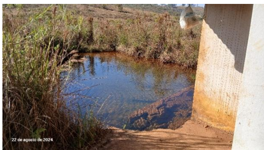
Foto 101: Poço de captação de água desativado (Coordenadas de Referência UTM 23K 553020 E 7705404 S).
