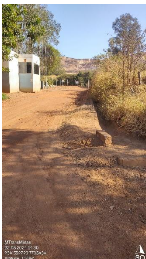
Foto 57: Canaleta em concreto disposta próxima à guarita de entrada ao empreendimento.
