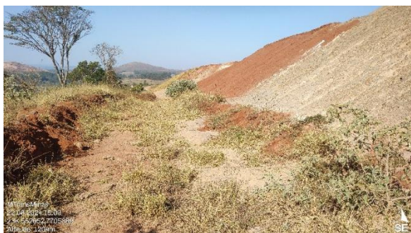
Foto 61: Drenagem em solo associada a talude de pilha de rejeito/estéril. Porção norte da ADA.
