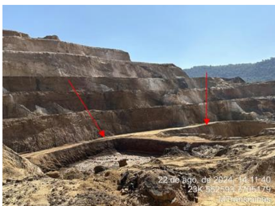
Foto 1: Setas vermelhas indicando cavas que estão atuando como SUMP's .
