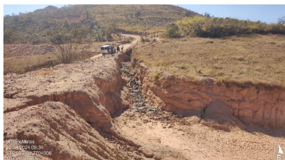
Foto 27: Caixa dissipadora de energia associada à drenagem construída. Porção sudoeste, fora da ADA.
