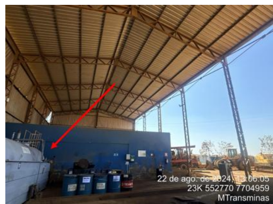
Foto 84: Vista geral do galpão onde se localiza o tanque de combustível (diesel).
