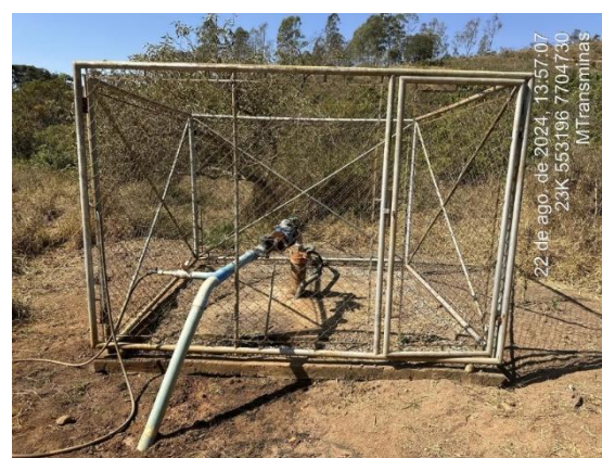
Foto 90: Vista da estrutura do poço artesiano 02.
