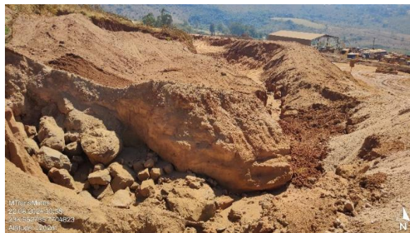
Foto 42: Canaletas em solo, que potencializam o transporte de sedimentos.
