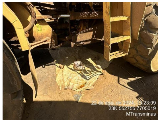
Foto 88: Vazamento de óleo em equipamento localizado em solo sem pavimentação. Foi colocado um pedaço de lona plástica como contenção.
