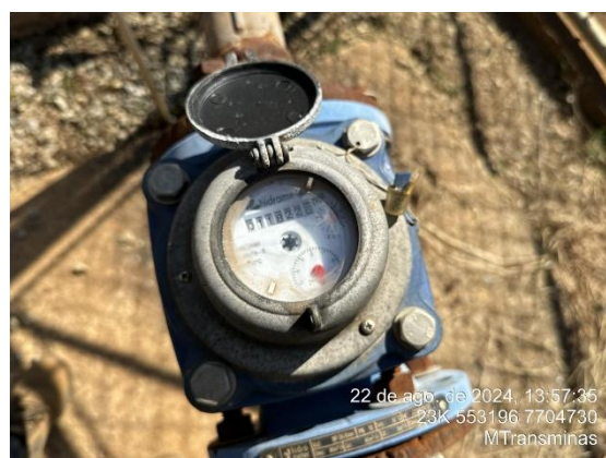
Foto 92: Hidrômetro poço 02.
