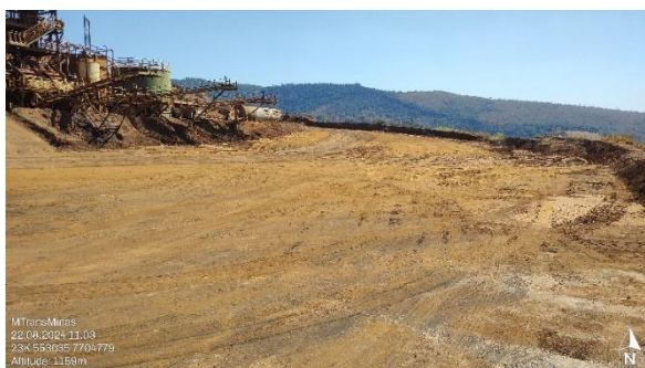
Foto 47: Pátio de beneficiamento de minério. Não há estruturas de drenagem. Nota-se o acúmulo de água na porção direita da foto.
