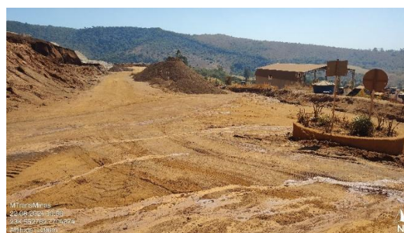
Foto 40: Área central da ADA – estruturas de apoio.
