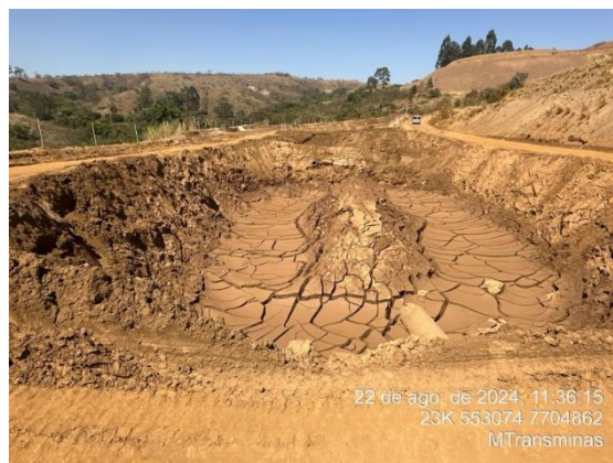
Foto 6: Seta indicando tubulação que conecta uma bacia de decantação à outra.
