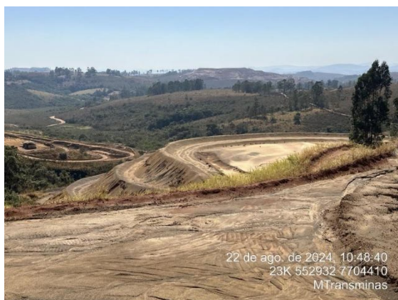
Foto 15: Pilha de rejeito.
