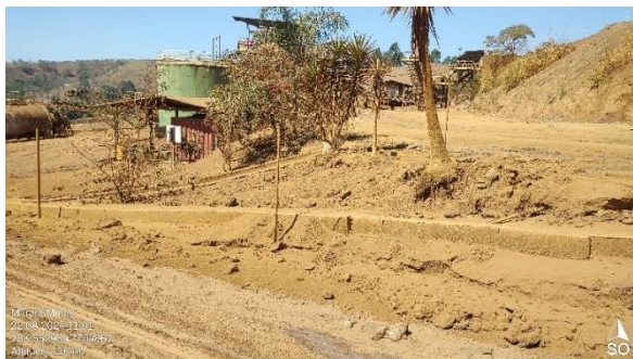
Foto 41: Canaletas em concreto dispostas na porção central da ADA. Não há dispositivos de contenção associados.
