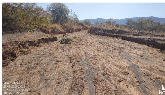
Foto 48: Drenagem espreada localizada na porção centro leste da ADA.
