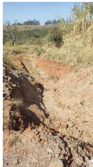
Foto 50: Exutório da bacia de contenção. A água que excede drena sobre o solo em direção ao ribeirão da Ponte Alta.
