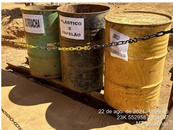
Foto 69: Tambor amarelo identificado como ser destinado a armazenar resíduos contaminados com óleo.
