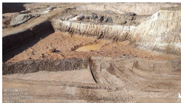
Foto 62: Bacia de contenção em área de mina. Porção centro norte da ADA.
