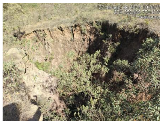
Foto 110: Outro ponto onde foi evidenciado ravina/voçoroca nas dependências do empreendimento.
