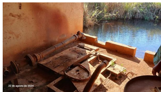
Foto 94: Local onde ficavam os dispositivos para captação de água superficial.
