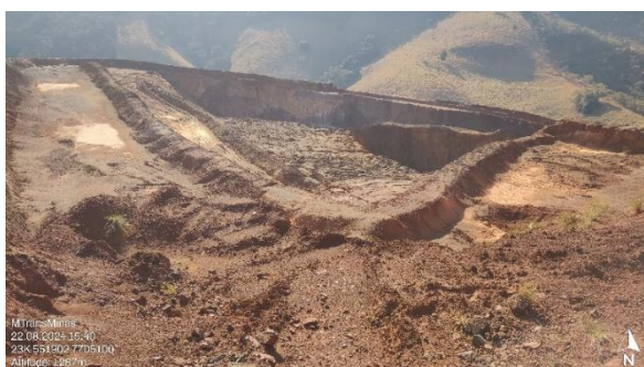
Foto 65: Bacia de contenção de sedimentos disposta na porção noroeste da ADA, em área de lavra de maior elevação topográfica.
