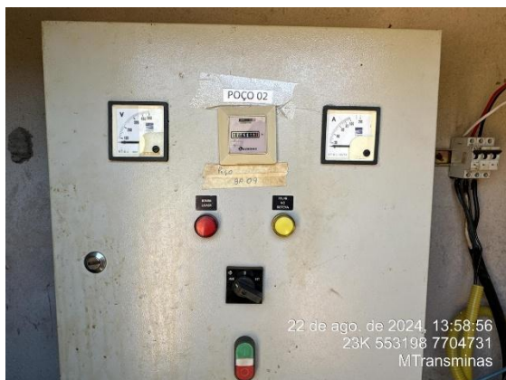
Foto 93: Horímetro poço 02.
