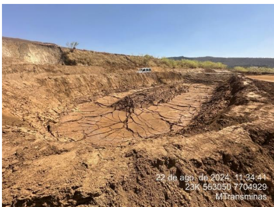
Foto 5: Bacia de decantação do efluente advindo da UTM a úmido.
