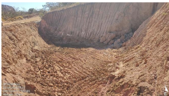
Foto 29: Bacia de contenção.
