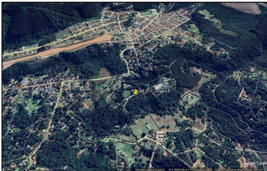
FIGURA 2: Imagem da área do Lote nº. 10-C, Quadra B, situado à Rua do Selado, Loteamento Balneário Monte Verde, Distrito de Monte Verde, Camanducaia/MG.
