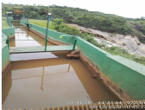
Foto 03. Canal de adução.
