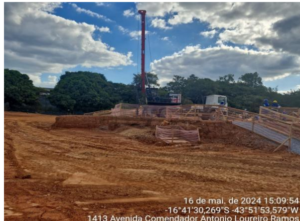
Foto 14 - Ampliação Abrigo de Resíduos
