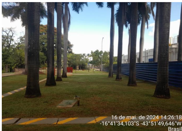
Foto 03 - Local da Passarela C5 e C7
