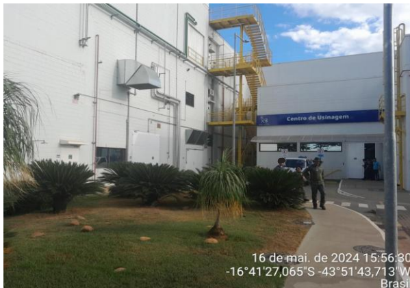
Foto 15 - Local Prédio dos Chillers
