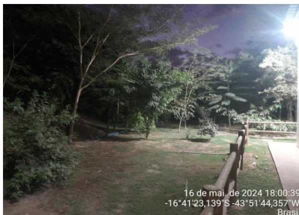
Foto 05 - Ampliação da Subestação
