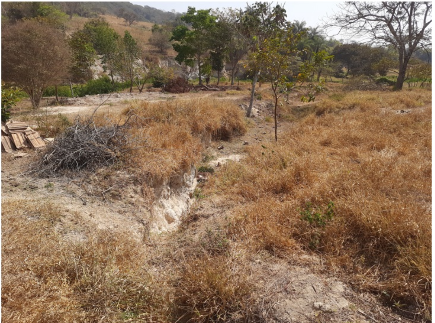
Canal de drenagem na passagem segundo Coordenadas Este 547355 m e Norte 7826919 m.
