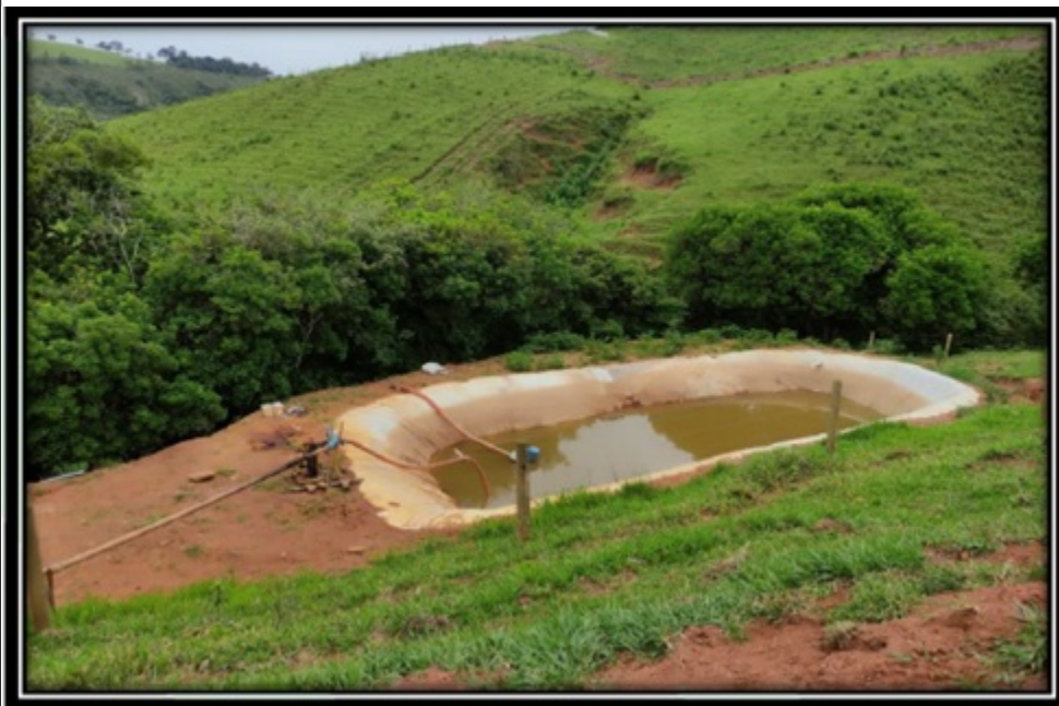
FIGURA 10: Imagem da intervenção ambiental em APP, construção de um tanque escavado, no Sítio Congonhas, Bairro Boa Vereda de Cima, município de Bom Repouso/MG.
