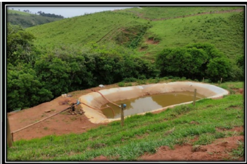
FIGURA 05: Local da intervenção ambiental em APP, construção de um tanque escavado, no Sítio Congonhas, Bairro Boa Vereda de Cima, município de Bom Repouso/MG.
