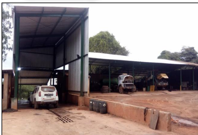
Foto 07 – Lavador e oficina principal do empreendimento (Relatório Técnico de Situação, 2022).
