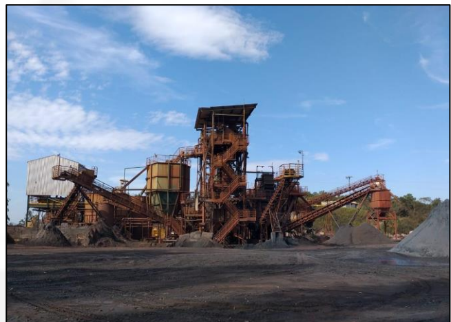
Foto 04 – Vista geral da UTM a úmido a ser ampliada/modificada (Relatório Técnico de Situação, 2022).
