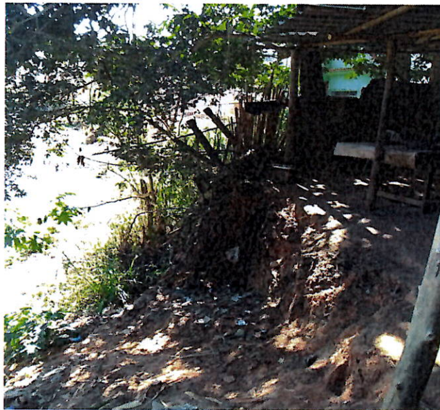
Foto 02: Registro fotográfico realizado no dia 23/07/2021 evidenciando o descarte de resíduos diretamente sobre as margens do Ribeirão Ubá e a instabilidade da encosta.
