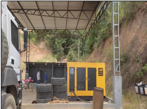
Foto 07 – Oficina para pequenas manutenções e baias para depósito temporário de resíduos sólidos (Vistoria SUPRAM/LM, 2022).
