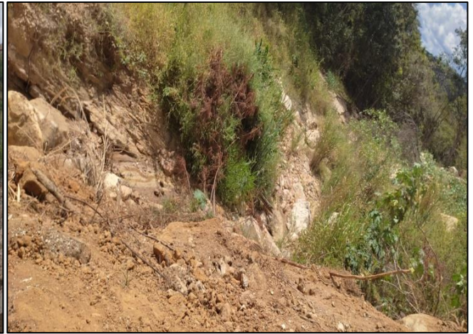
Foto 06 – Vista parcial da pilha de rejeito/estéril 2 com destaque para linha de drenagem (Vistoria SUPRAM/LM, 2022).
