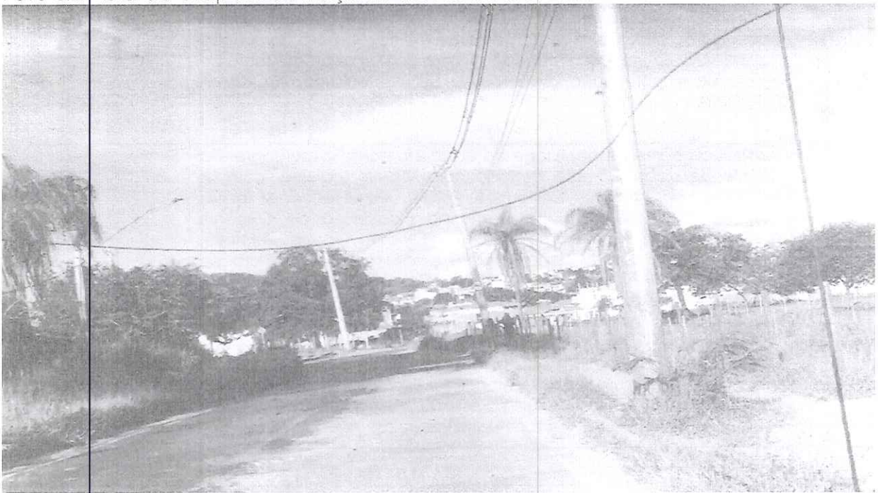
Foto 02: vista da etapa 2 do traçado da via do Icaivera
