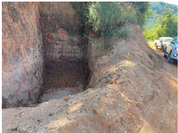
Foto 08. Sistema de drenagem pluvial da via de acesso (bacia de sedimentação).
