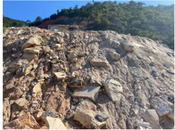
Foto 06. Pilha de Rejeito/Estéril
