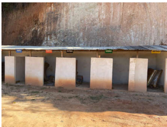
Foto 04. Baias para armazenamento de resíduos sólidos.
