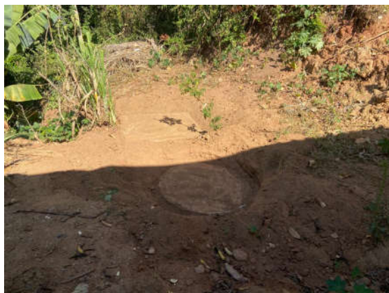
Foto 01. Fossa séptica e sumidouro.
