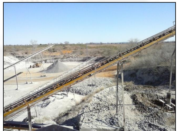
Foto 18: Área de britagem
