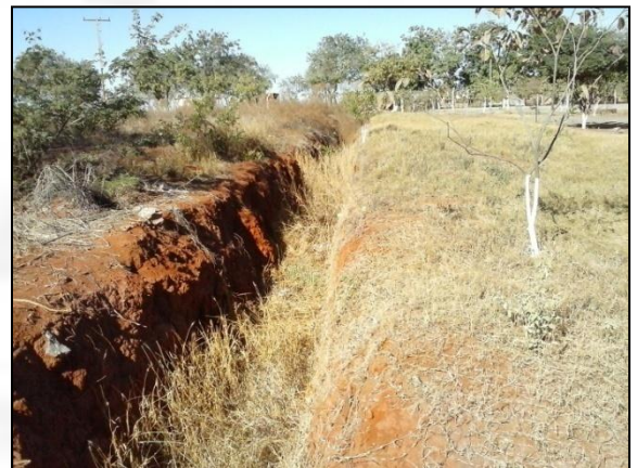
Foto 10: Drenagem de água Pluvial
