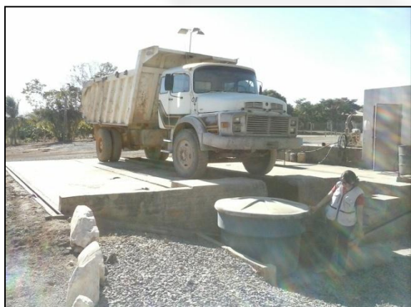
Foto 05: Área de lavagem e troca de óleo
