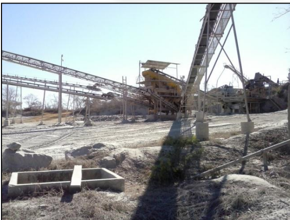
Foto 15: Área de britagem
