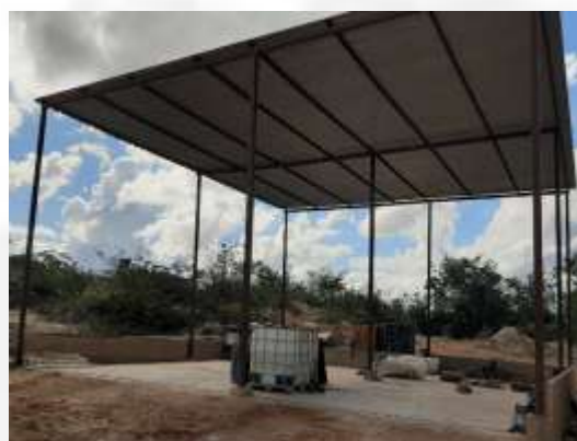
Figura 04: Galpão de Máquinas Fonte: RCA – Fazenda Rio Pardinho.
