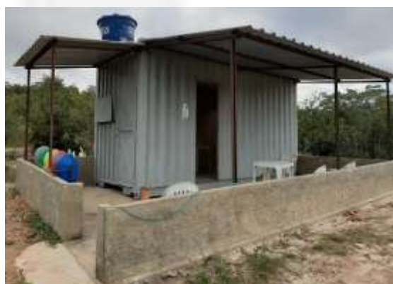
Figura 03: Container (refeitório) Fonte: RCA – Fazenda Rio Pardinho.
