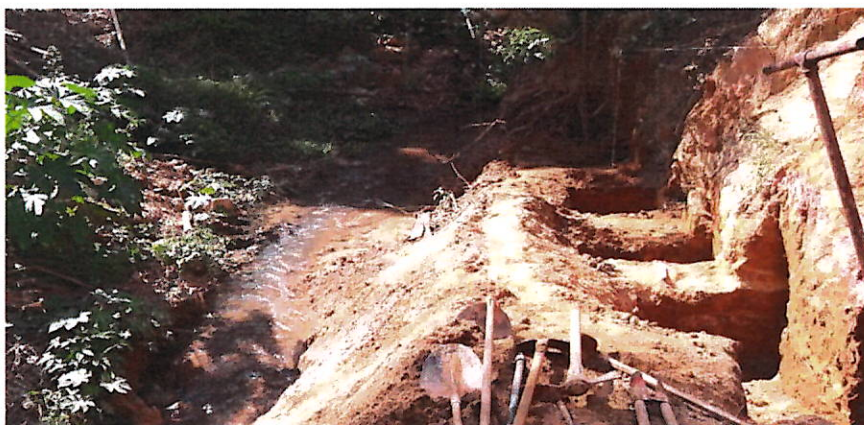
Foto 01: Foto do local da intervenção, início da edificação do muro
