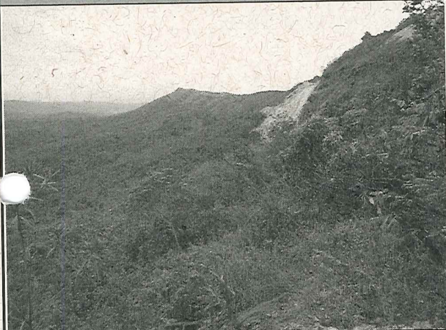
Foto 01: Área de intervenção - acesso operacional
