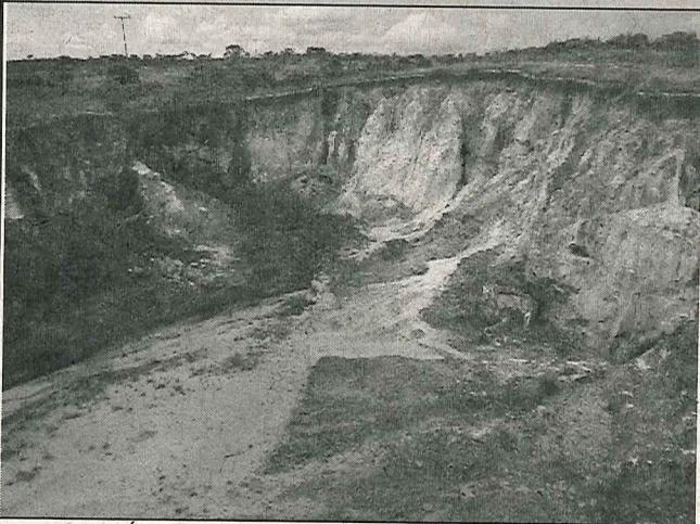
Foto 01: Área solicitada para intervenção.
