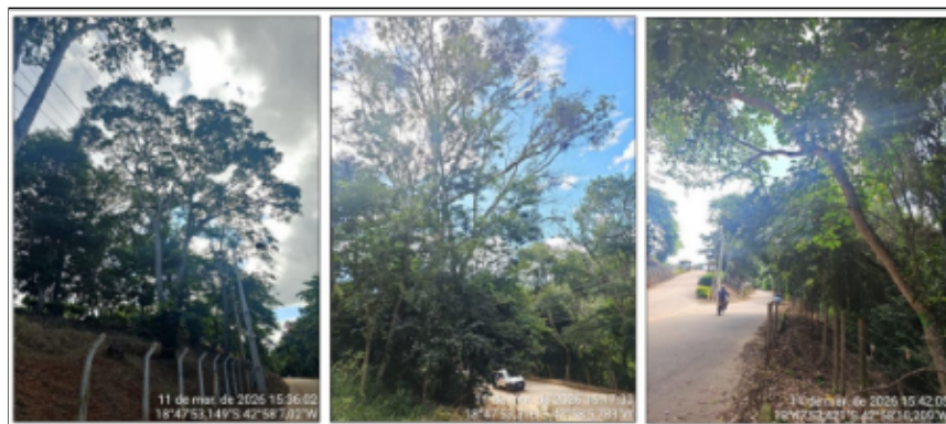
Árvores com risco de queda (Intervenção Convencional).
