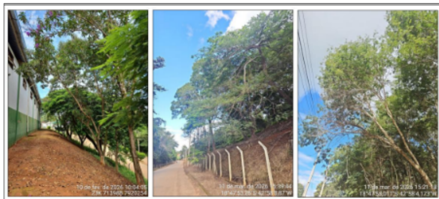
Árvores com risco de queda (Intervenção Convencional).
