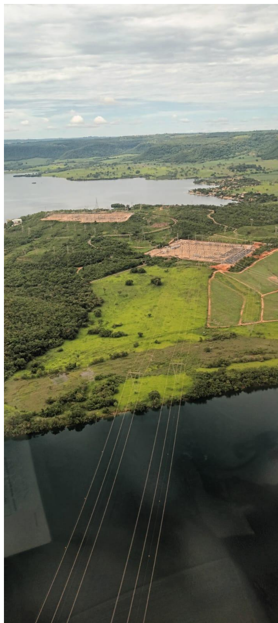
Figura 4: Área Diretamente Afetada. Subestação Jaguara (Rifaina – SP)
