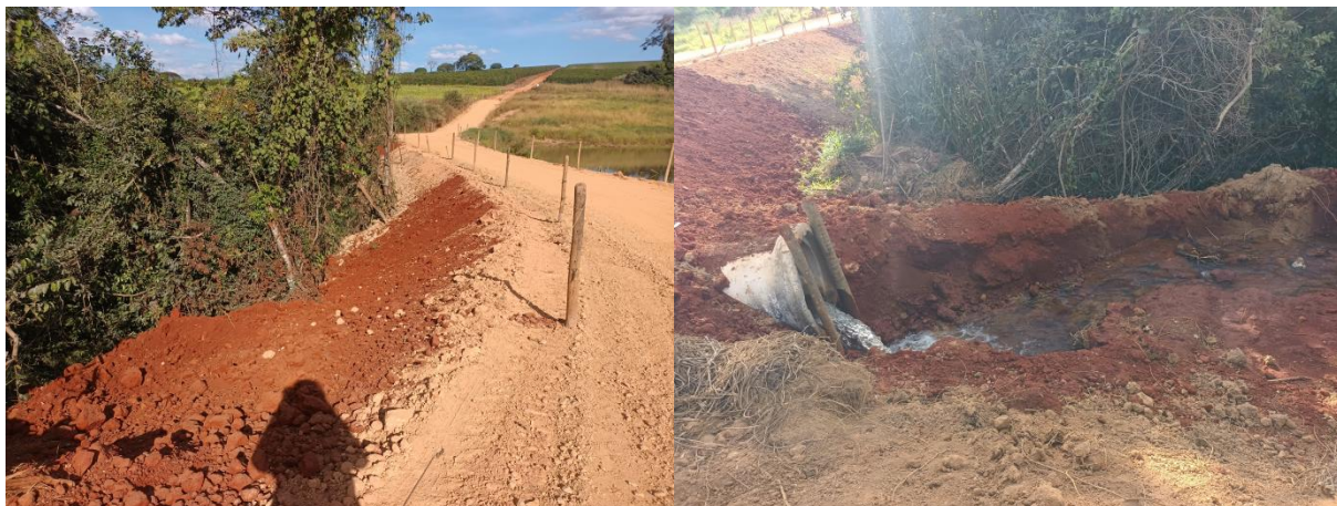
Fotos 1 e 2: Conformação do talude e manilha extravasora
