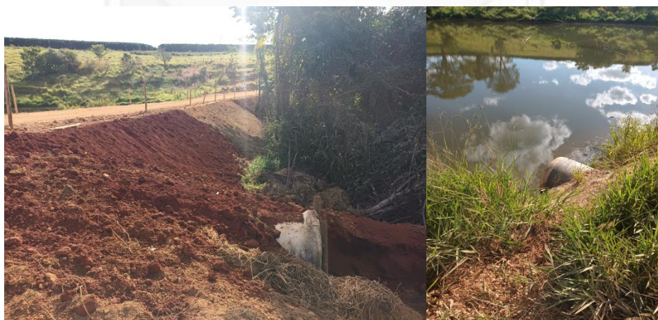
Fotos 3 e 4: Conformação do talude e barragem
