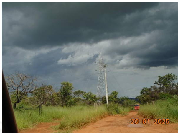
Foto 01: Início da linha de distribuição instalada Fonte: SEMMA
