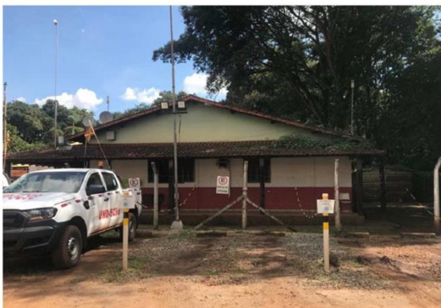
Figura 5-13: Antiga edificação do Clube Social da Vila Ferteco de Córrego do Feijão, atualmente utilizado para Base Bravo do Corpo de Bombeiros, Brumadinho – MG.
