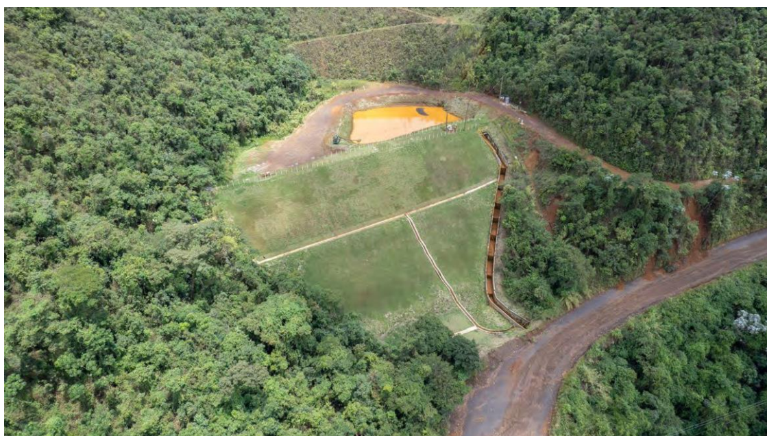
Figura 2: Vista da Barragem B-VII a ser descaracterizada. Fonte: VALE, EIA, 2023.
