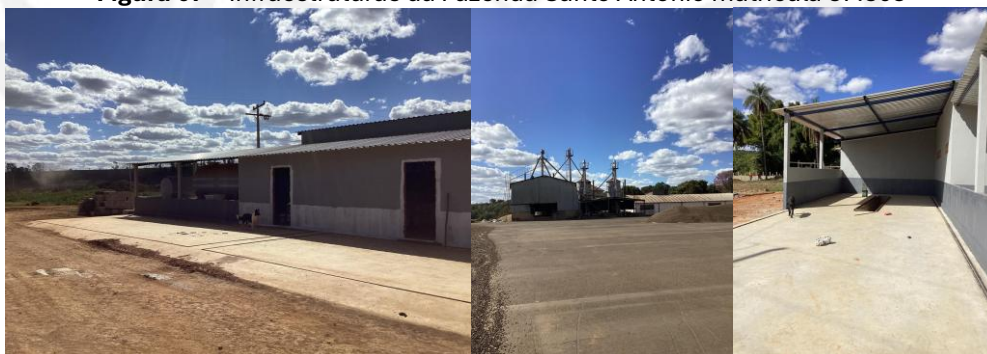
Figura 08 – Infraestruturas da Fazenda Santo Antônio – sede principal
