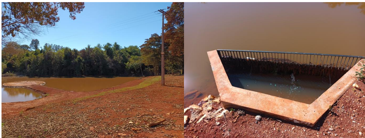
Fotos 1 e 2: Barragem com construção do pier – canal vertedouro
