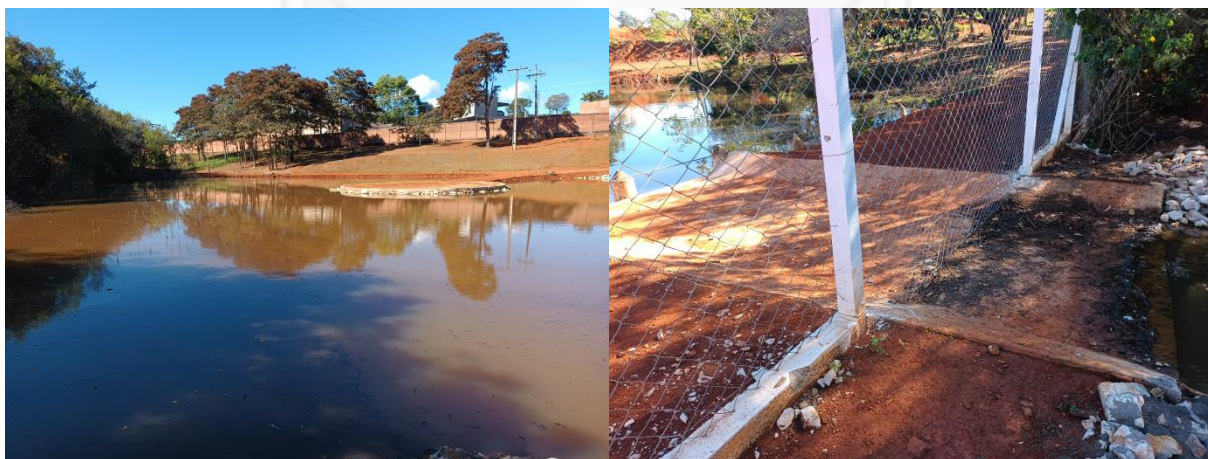
Fotos 3 e 4: Barragem – talude e canal extravasor instalado na margem direita do talude
