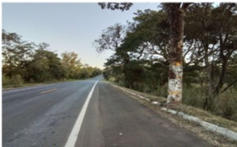
Figura 1: Proximidade de um indivíduo arbóreo, localizado na faixa de domínio da rodovia, na altura do Km 050+550, sentido sul, a 0,30 metros do bordo do acostamento da MG-231.
