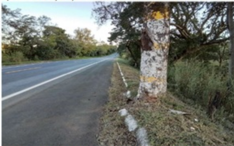
Figura 2: Proximidade de um indivíduo arbóreo, localizado na faixa de domínio da rodovia, na altura do Km 050+550, sentido sul, a 0,30 metros do bordo do acostamento da MG-231.
