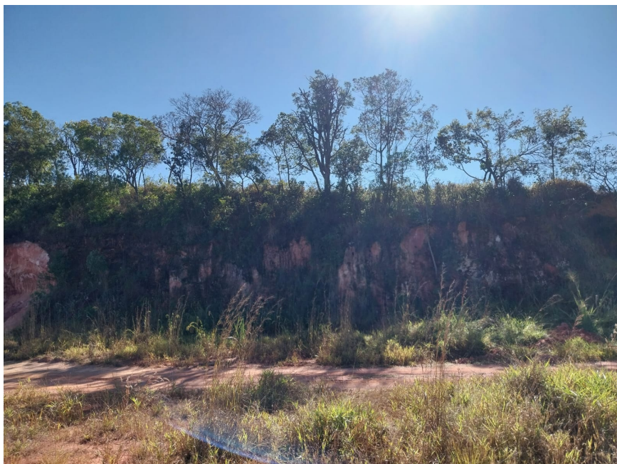
Foto 1: Vista frontal do barranco existente na propriedade.
