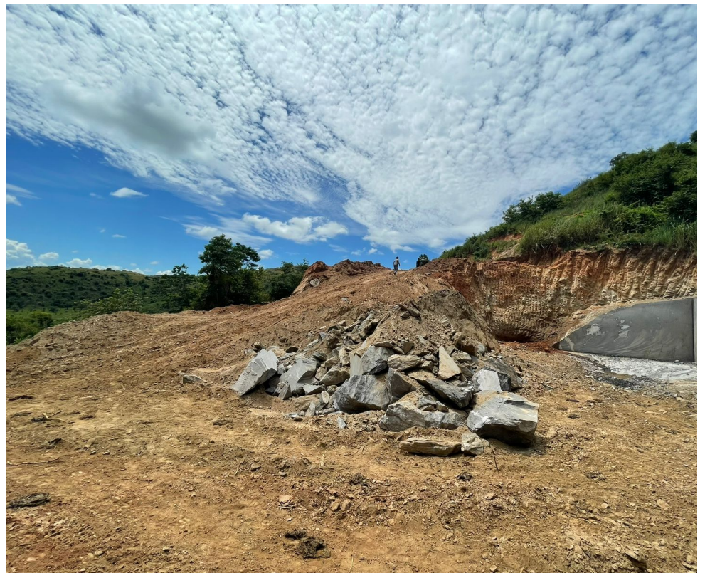
Figura 4. Foto das intervenções constatadas em 19/03/2026 - decapeamento e extração da rocha granítica
