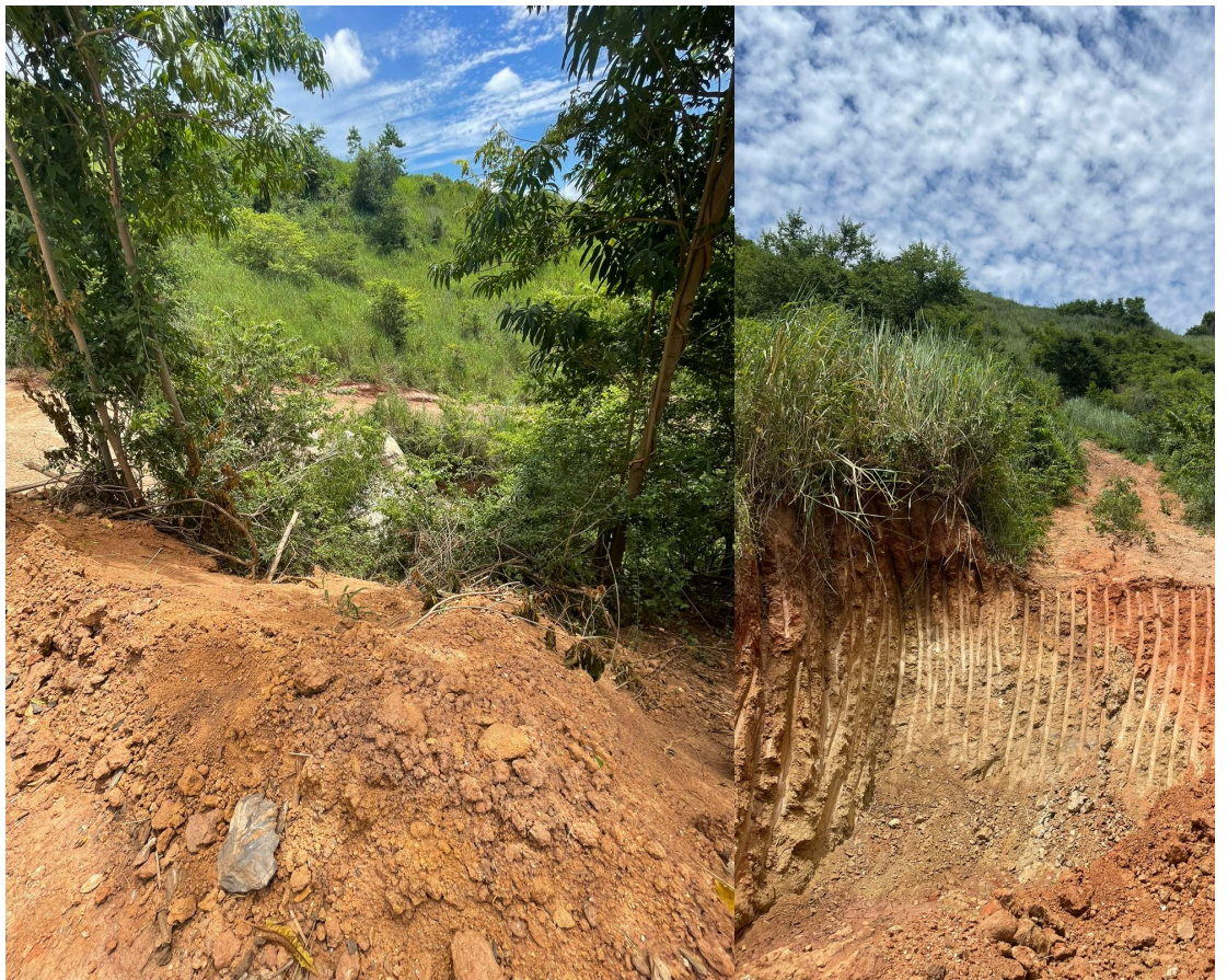
Figura 5: Fotos das intervenções constatadas em 19/03/2026 - Evidências do uso maquinário, material lenhoso e terra direcionados p
