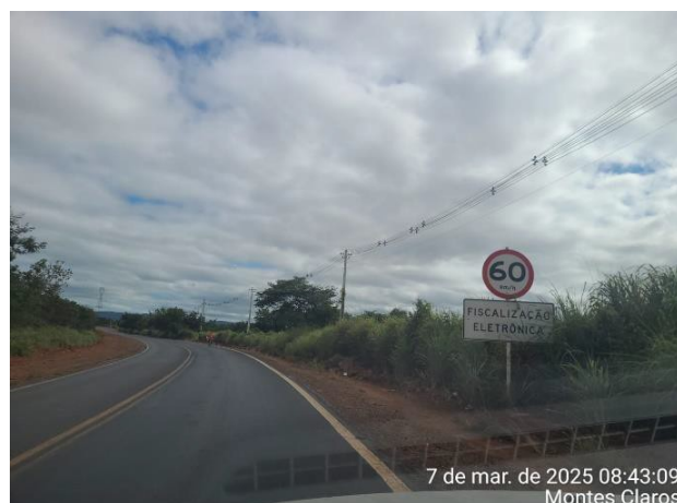
Foto 04 - Em andamento alargamento dos acostamentos.
