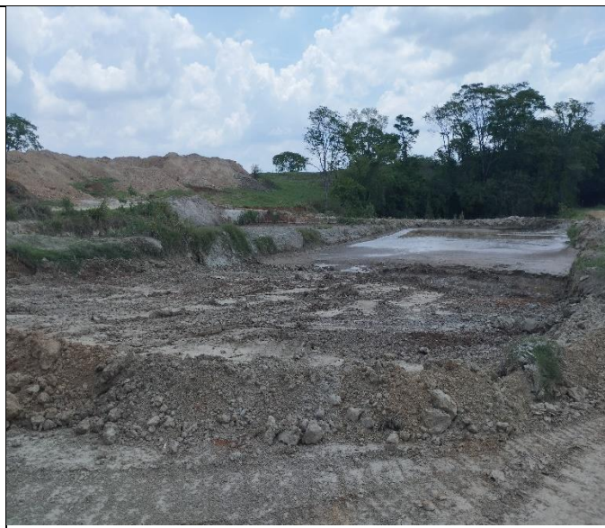
Foto 4: Diques de drenagem e desidratação da lama decantada nas bacias de decantação da UTM
