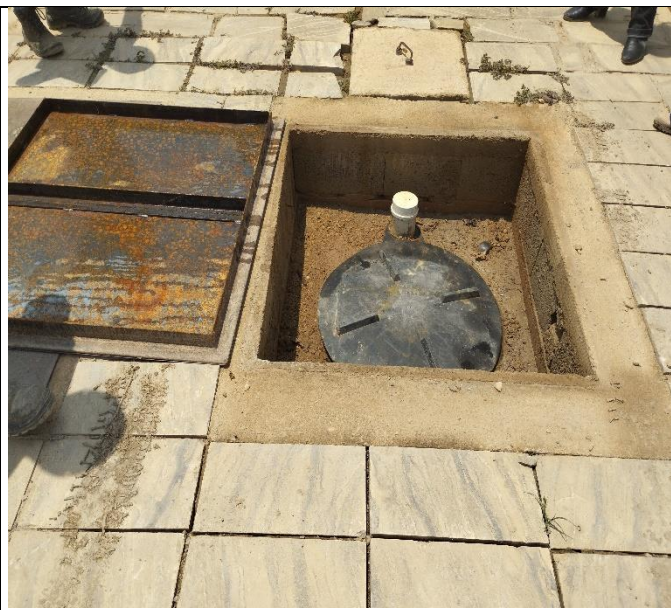
Foto 6: Biodigestor que trata o efluente doméstico gerado no empreendimento
